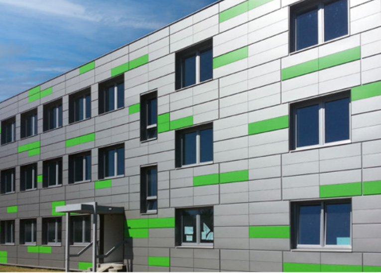
UBYTOVNA AUTOGAMES – U. HRADIŠTĚ
