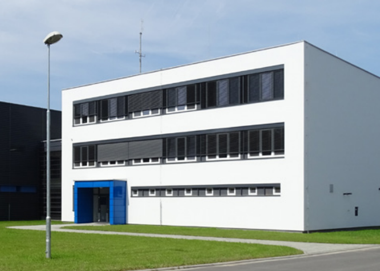
ÚPRAVNA VODY – BŘECLAV
